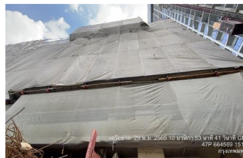
รูปที่ 38 ผ้าใบ (Mesh Sheet) คลุมโดยรอบตัวอาคาร (ปัจจุบันรื้อถอนเรียบร้อยแล้ว)
