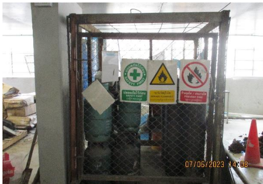
รูปที่ 22 พื้นที่เก็บวัสดุไวไฟ/เชื้อเพลิง และป้ายเตือนอันตราย
