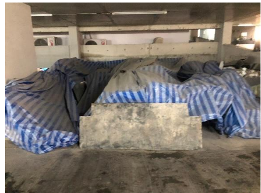
รูปที่ 23 การปิดคลุมวัสดุก่อสร้าง
