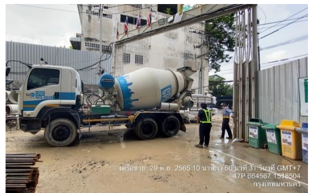
รูปที่ 18 จุดล้างล้อรถ และการทำความสะอาดล้อรถก่อนออกนอกพื้นที่โครงการ (ปัจจุบันรื้อถอนเรียบร้อยแล้ว)
