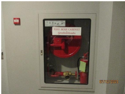
รูปที่ 19 ถังดับเพลิงเคมี และป้ายการตรวจเช็คสภาพการใช้งาน
